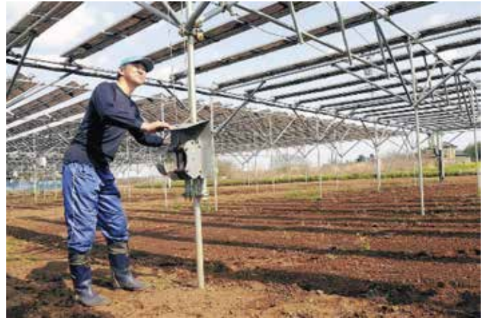
▲複数ソーラーパネル同時角度調整用
