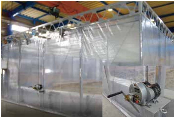
▲天井搬入用ビニール屋根開閉用
