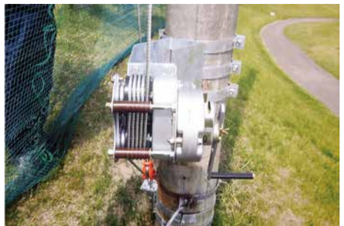
▲ゴルフコース内間仕切り防球ネット複数面同時昇降用（2台で8面）
